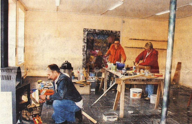
Fleißige Handwerker bei der Arbeit im zukünftigen Probenraum der Bläferschule, von links Rupert Maierl, Susanne Reindl und Jutta Haisch.
